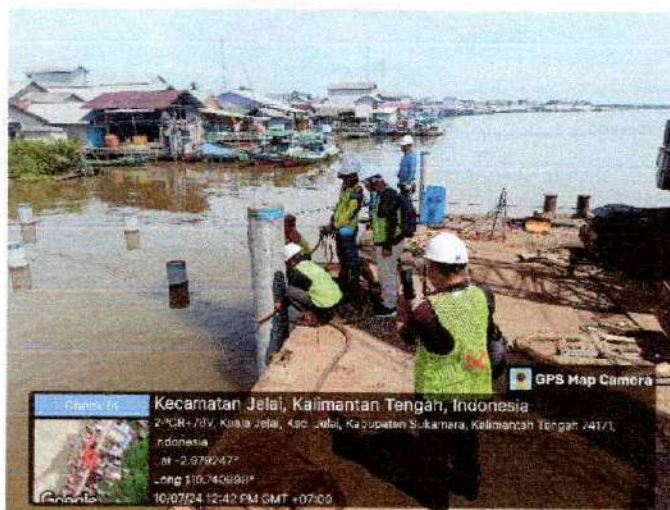
Pengujian PDA Test
